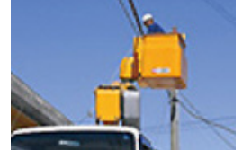
災害後の通信ケーブルの応急復旧作業
